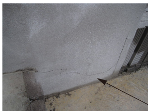
住宅の基礎外装のひび割れなどは補修用モルタルを上から塗布して補修します
