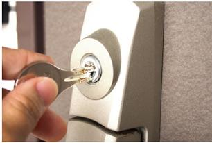
鍵穴に、ゴミや土埃などが入り込んで回りにくくなることがあります。定期的にパソコンキーボード用のエアダスターなどでゴミや土埃を吹き飛ばしましょう。掃除機での吸い取りも有効です。『**鍵穴専用の潤滑油**』を使用すると回りがよくなります。潤滑油でも鍵の動きがよくならなければ、鍵本体の部品が劣化したり摩耗や損傷が発生している可能性があります。その場合は交換が必要となります。
