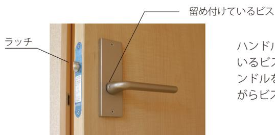
ハンドルがぐらぐらする場合は、レバーハンドルを留め付けているビスを緩め、レバーハンドルを引き抜き、再度、レバーハンドルを差し込みます。レバーハンドルを両側から強く押ししながらビスを締めつけ、ぐらつきが無いかを確認して完了です。
