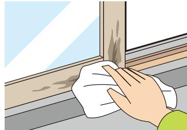
キズにより腐食して錆が出た場合は、市販の金属専用のクリーナーやアルミ用さび落としを使用し落としましょう。
