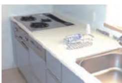
天板・壁面・扉面・換気扇まわり
